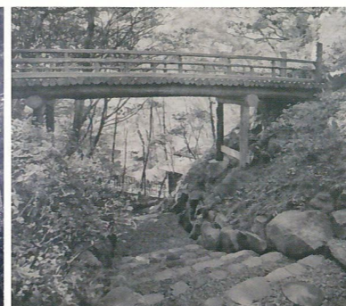
流雲橋：階段の上にかけていられた橋げたの礎石の一部が現在でも残っています
