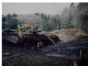
座間谷戸山公園 水鳥の池 (造成中)
