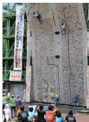
山岳スポーツセンター リードウォール
