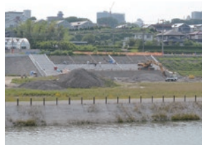
境川遊水地公園 今田管理センター(造成中)
