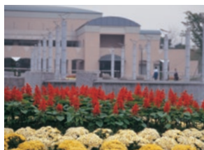
かながわアートホール (オープン後)
