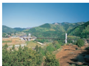
秦野戸川公園（造成中）
