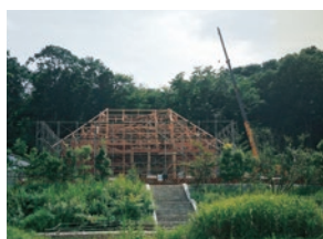
座間谷戸山公園 里山体験館（建築中）
