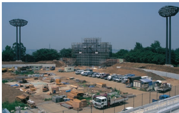
改築中の保土ケ谷公園野球場
