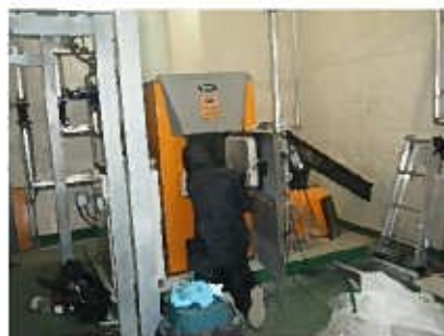
バイオマスボイラー点検
