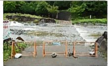
「沢の橋」の通行止め措置
