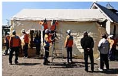
防災パーゴラの設営
