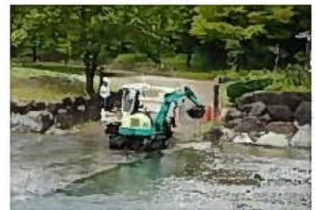
バックホーによる河川土砂の管理
