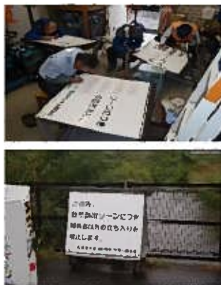
案内看板 補修作業
