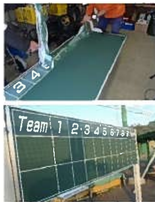
スコアボード補修作業
