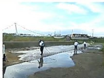
洪水発生時の作業の様子
