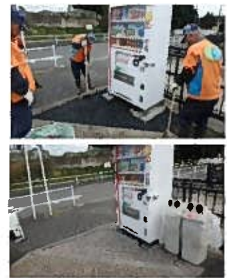
段差解消・廃材利用の舗装作業
