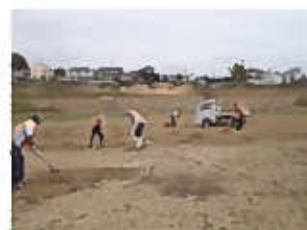
芝生に堆積した土砂の除去作業
