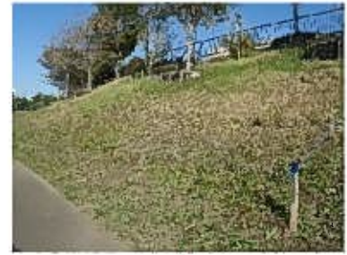
法面草刈りの様子
