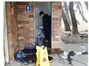
高圧洗浄機による トイレ清掃状況
