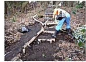
発生材を活用した小破修繕
