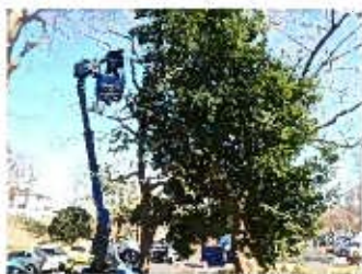
高所作業車による枝処理
