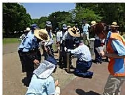
緊急車両入口開放・点検
