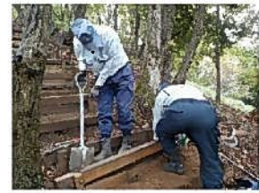
発生材を活用した小破修繕
